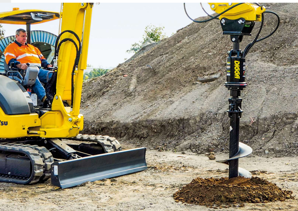
Präzision von der Kabine aus. Der Maschinenführer benötigt dank Halo keinen Kollegen mehr, der die Bohrung überwachen oder Abweichungen korrigieren muss. Hier zeigt die rote Kontrollleuchte dem Maschinenführer, dass die Bohrung nicht passt.
