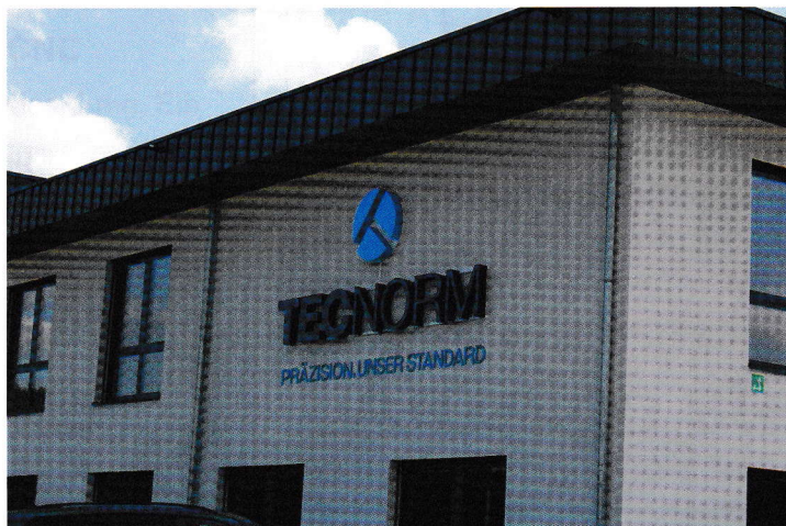
Der Qualitätsanspruch von TECNORM ist an der gut gedämmten Außenwand zu sehen (Bilder: TECNORM GmbH & Co. KG)
