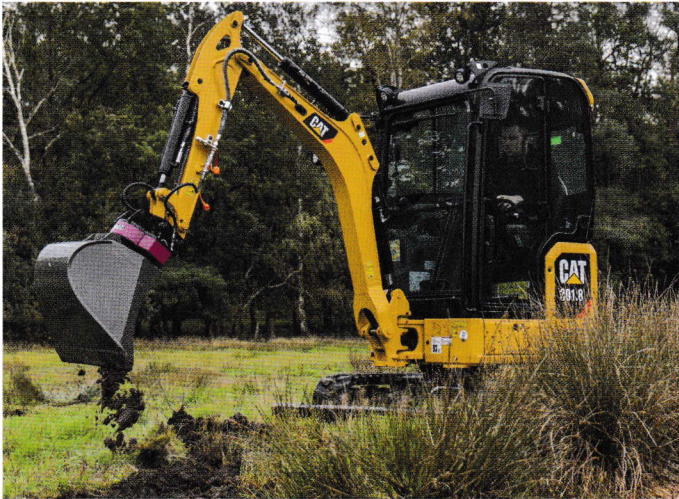
Profilieren, Modellieren und Abziehen: In Kombination mit dem Roto-Top können diese Arbeiten in einem Arbeitsgang erledigt werden. | Fotos: Holp
