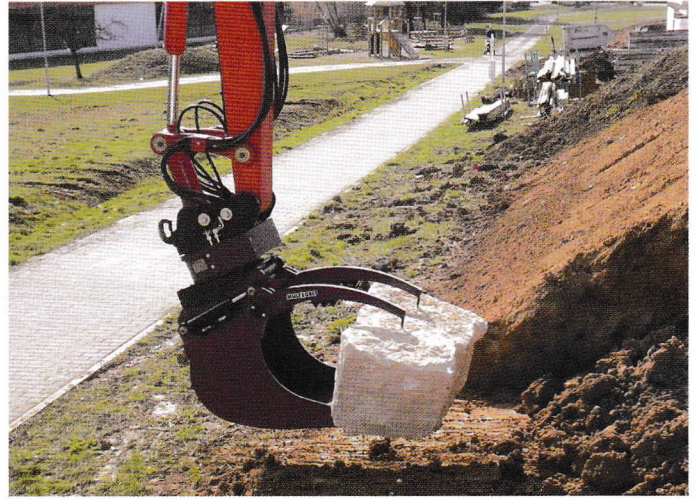
Der Multi-Grip greift und transportiert Erde und eignet sich zudem dafür, schwere Steine zu platzieren.
