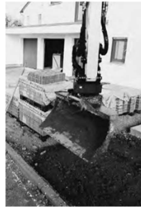
Durch die Flexibilität des RotoTop kann mit großer Präzision entlang der Hauswand in sehr beengten Verhältnissen gearbeitet werden, ohne dass hier etwas beschädigt wird, informiert Holp. FOTOS: HOLP
